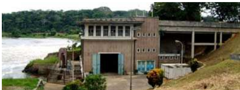
La centrale sur la Tshopo à Kisangani. Des trois turbines installées dans les années 50 et 70, une seule fonctionne encore
