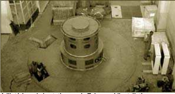
A l'intérieur de la station sur la Tshopo - L'installation en premier plan est la superstructure de la turbine stabilisée par le CICR
